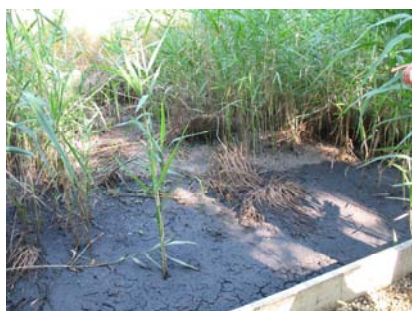
Boue sur lit de séchage
