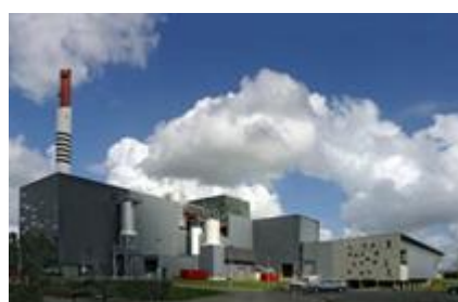
L'usine Arc-en-ciel (source photos © Agence Roulleau / Philippe Ruault)
